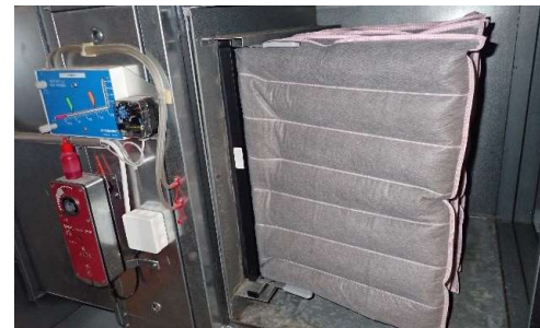
Suodattimien puhtaus ja suodatinkehysten tiiveys
