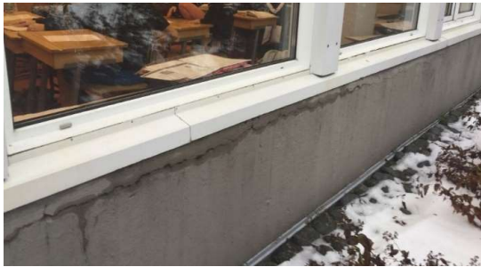
Ulkopuolisten rakenteiden tiiveys, ulkopuolinen vedeneristys
