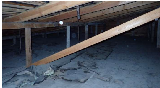
Yläpohjan tuulettumisedellytykset, vesikaton ja aluskatteen kunto
