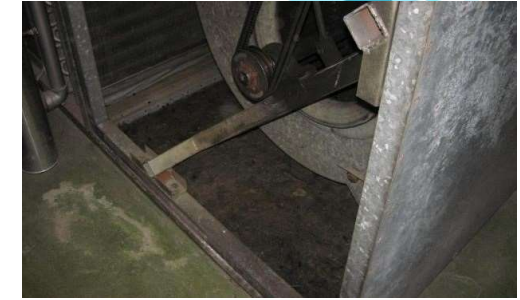
Puhaltimien silmämääräinen tarkastus. Ilmanvaihtokoneiden puhtaus ja äänenvaimentimien laatu ja kunto
